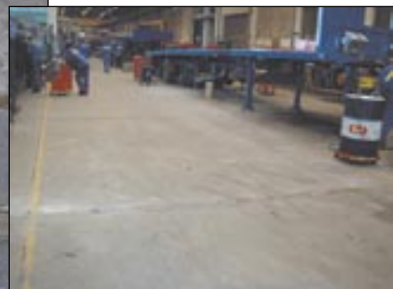
Fahrzeugwerke Faymonville AG, Billingen/Belgium: Repairing expansion joints
