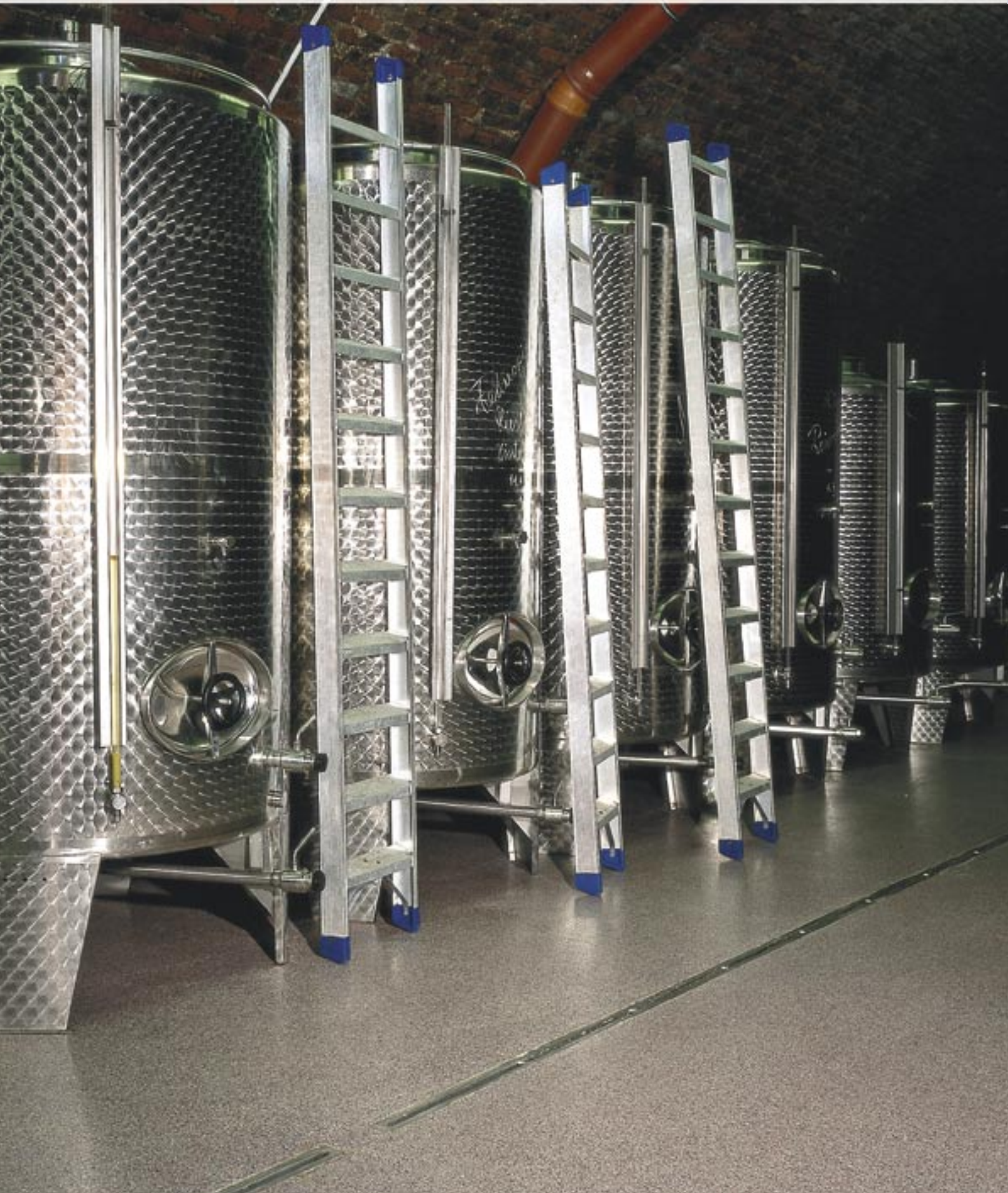
Silikal flooring systems Karl Stierschneider vineyard, Weissenkirchen/Austria
